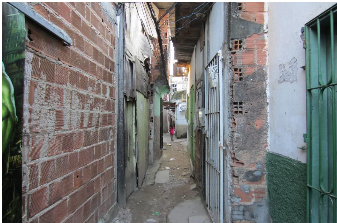
Figura 29 – Rua não urbanizada na comunidade Roque Santeiro na ZEIS Coelhos
