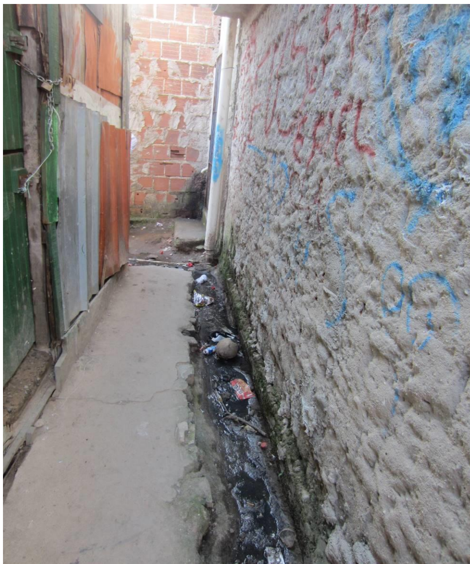
Figura 31 – Vala aberta para escoamento de esgoto na comunidade Roque Santeiro na ZEIS Coelhos
